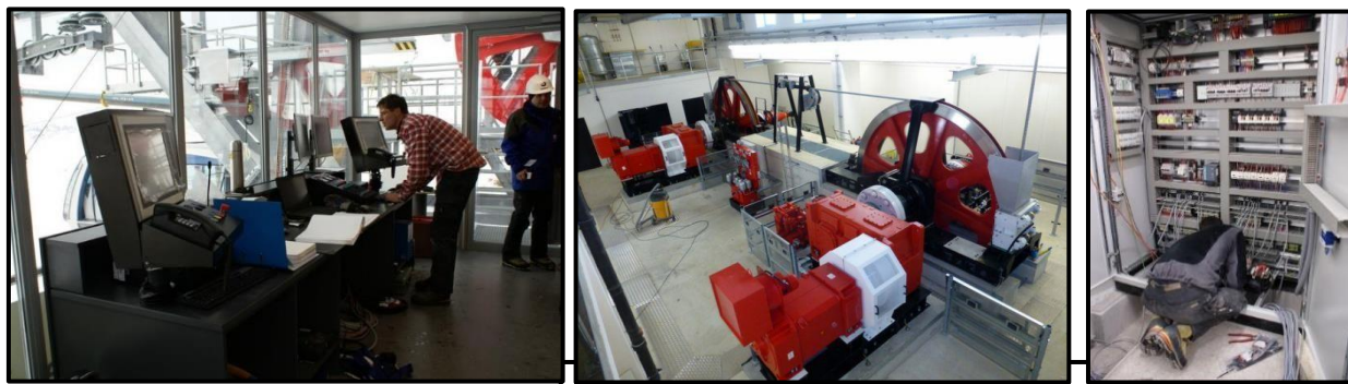
Slika 2.7 Pogonska postaja – komandni prostor (lijevo), pogonski sustav (u sredini), montaža procesne opreme (desno) (Izvor: Idejno rješenje)
