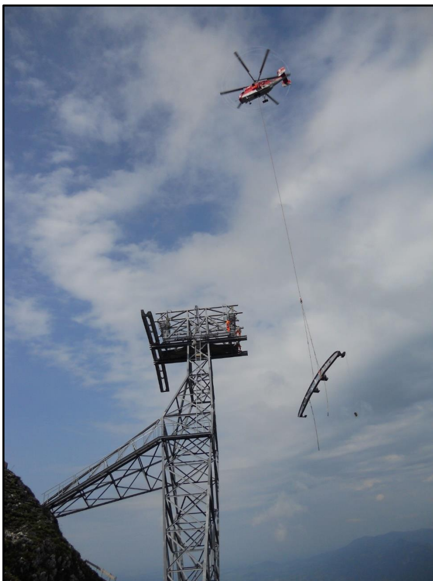
Slika 2.26 Postavljanje nosivog stupa iz zraka (Izvor: GARAVENTA AG)
